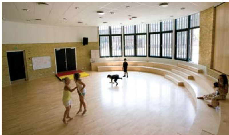
Heldækkende akustiklofter samt vægabsorbenter har været medvirkende til en forbedring af lydmiljøet.
