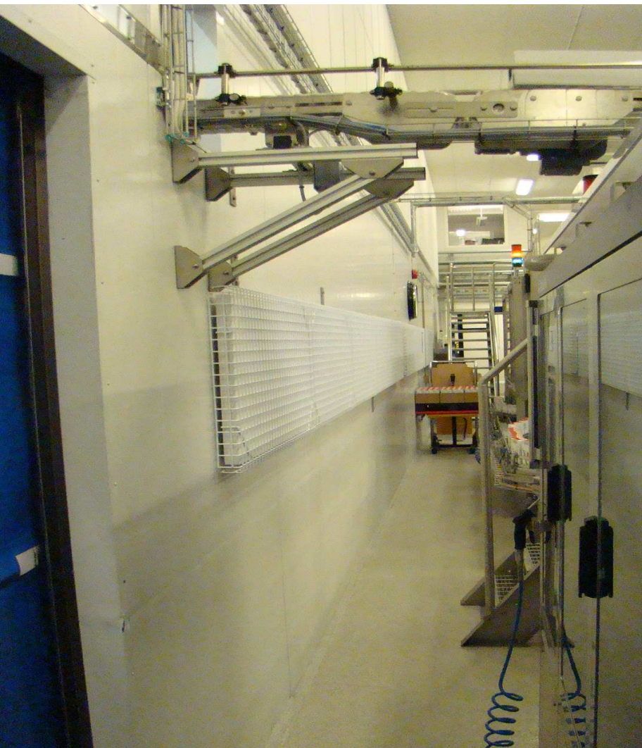
Figure 9. Hygiene Advance Protection C3 na ścianie w sąsiedztwie hałaśliwej linii.
