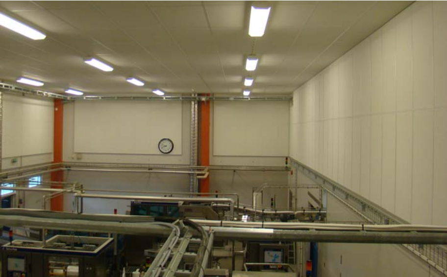
Kuva 8. Oatly'n tehtaaseen asennetut katto- ja seinälevyt.
