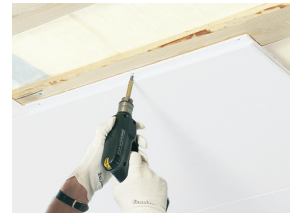
Fijación mecánica de las placas Focus F
