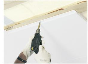
Focus F è installato per viti di fissaggio
