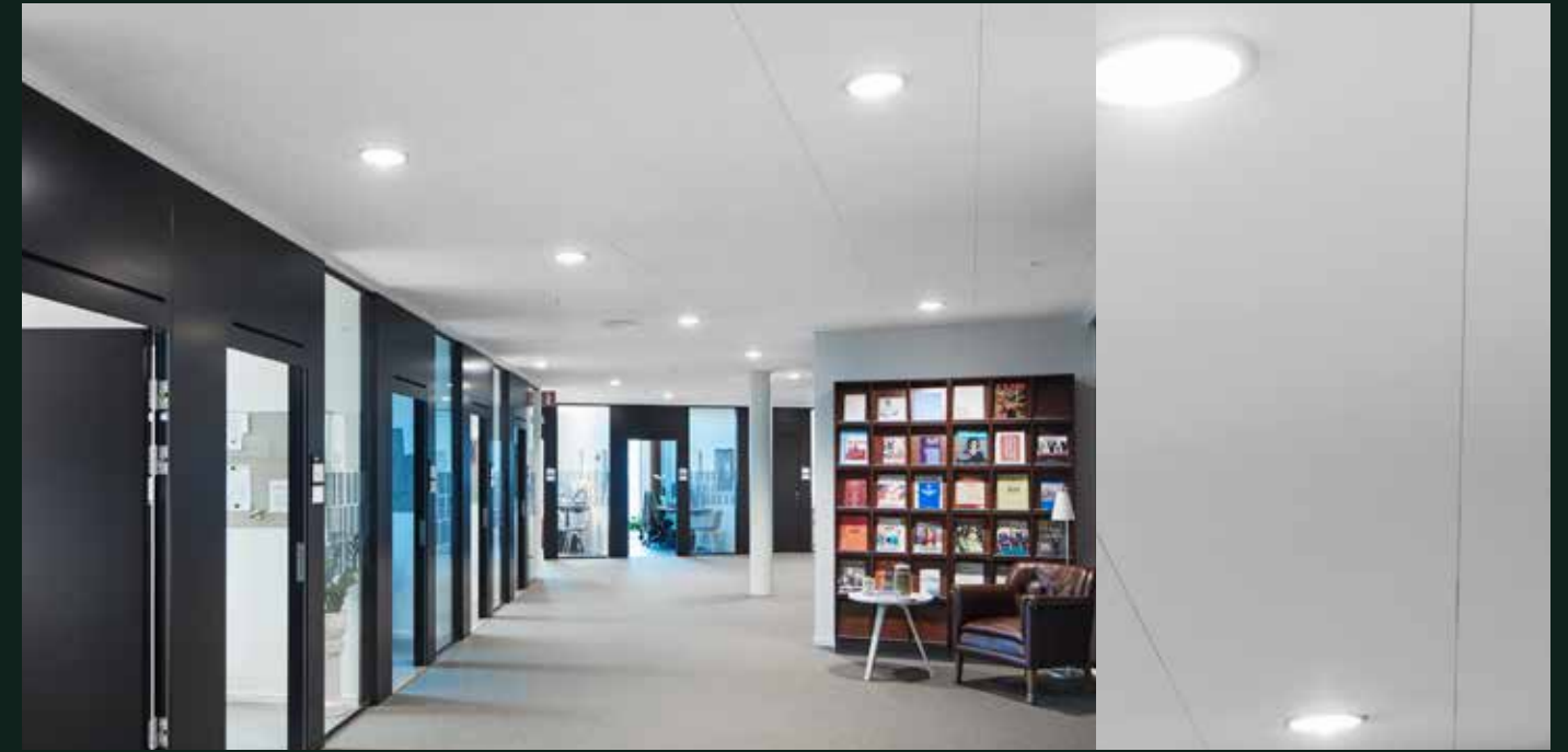
FOCUS™ Ds Les chants sont biseautés et forment une rainure discrète entre les panneaux. Système d'ossature cachée.
