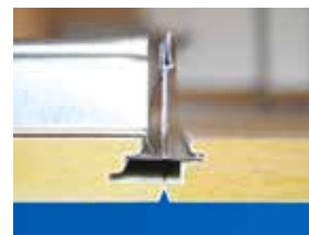
Przekrój Focus Ds mocowania z profilem Connect Bridging
