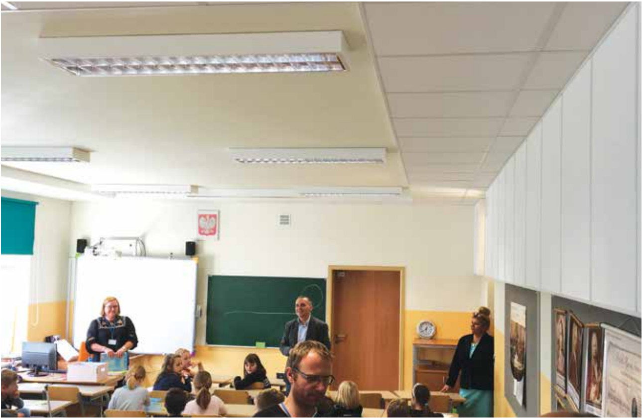
Jedna z sal lekcyjnych po modernizacji akustycznej. Ograniczona powierzchnia paneli dźwiękochłonnych na suficie ze względu na niewielką wysokość pomieszczenia
