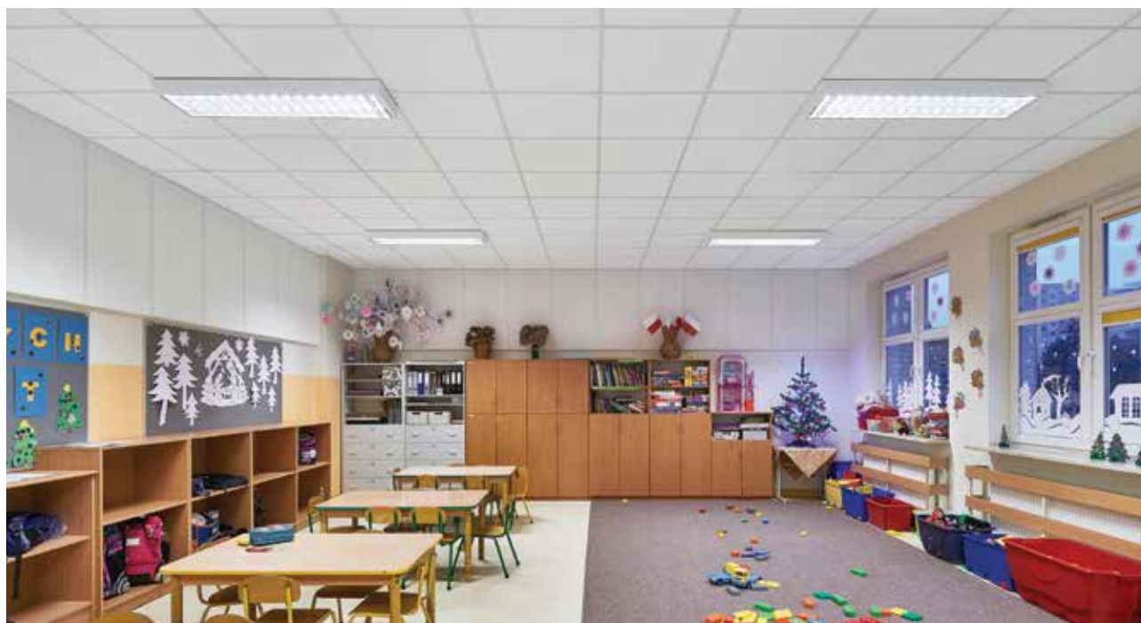
Jedna ze świetlic na parterze po modernizacji. Panele ściennie instalowane tuż pod sufitem aby uniknąć kolizji z istniejącym meblowaniem.
