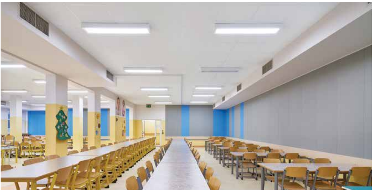
Stołówka po wyciszeniu. Zwraca uwagę stosunkowo duża powierzchnia paneli dźwiękochłonnych (szare i niebieskie pola).
