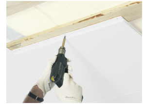
Focus F monteret med skruer
