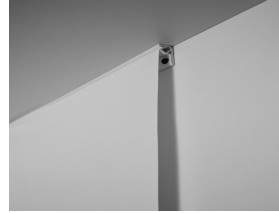
Clipso seinäasennus PCC-profiililla.
