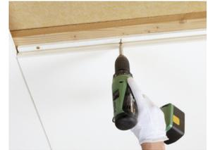
Монтаж Master F с помощью саморезов
