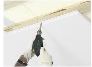
Fijación mecánica de las placas Focus F
