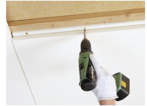
Master F è installato con fissaggio a vite.
