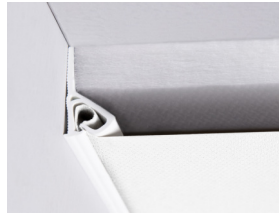
Clipso stropní montáž s PCW profilem.
