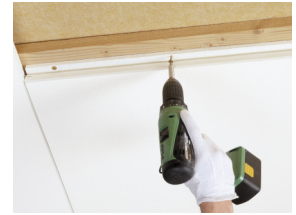
O Master F é instalado por fixação com parafusos
