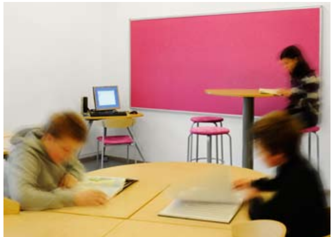
In een klaslokaal reduceren wandabsorbers het geluidsniveau en voorkomen ze ongewenste geluidsreflecties.
