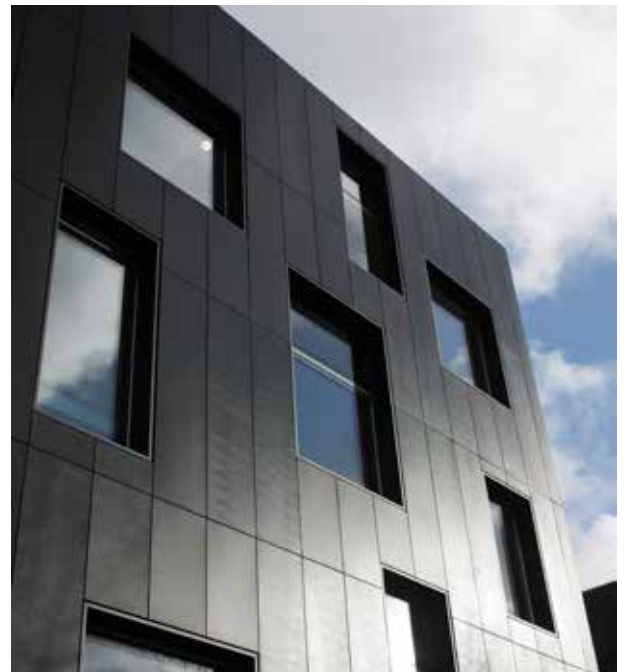
Ein klar und schlicht gehaltener Anbau mit schwarzer Aluminiumfassade und tiefen Fensternischen, der mit der Architektur des vorhandenen Gebäudes harmoniert.
